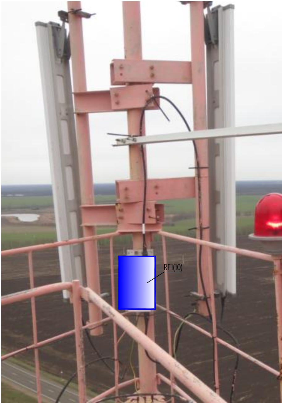
Место установки проектируемого FHDB около секторной антенны A1.1 и A3.2
