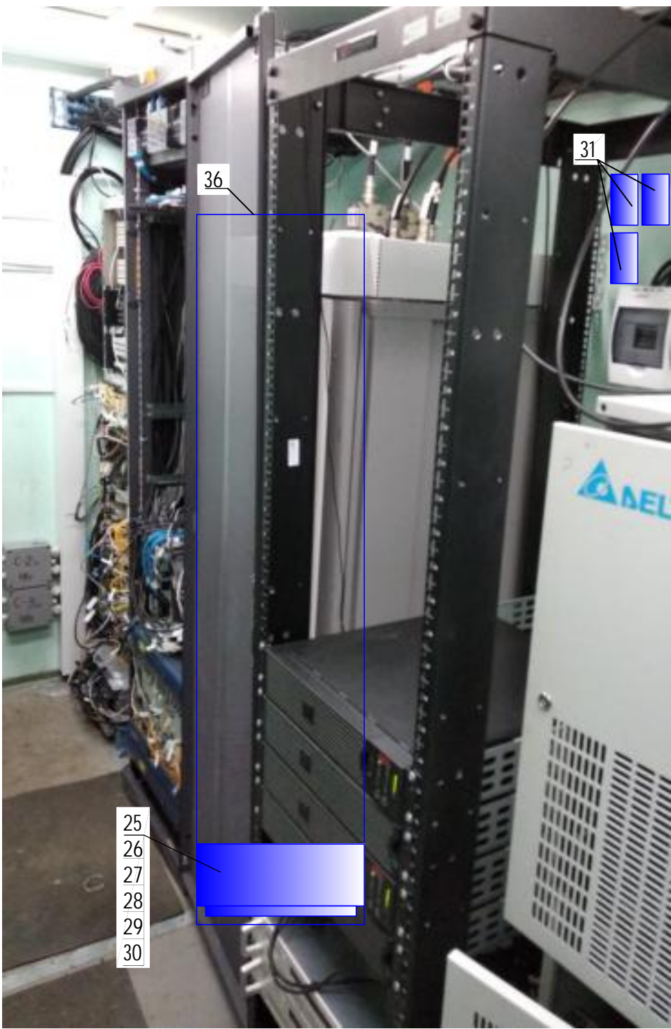
Место установки SM1 FSMF (GSM-900 ) в 19"стойку
